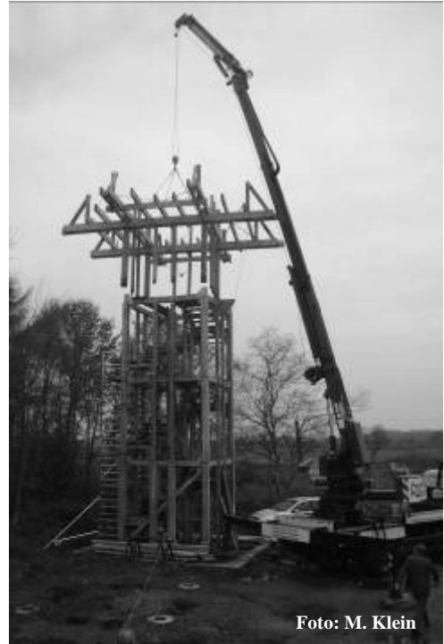
Abb. 2: Das oberste Stockwerk mit der Aussichtsplattform wird aufgesetzt (Nov. 2004)
