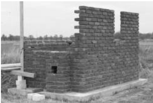
Abb. 3: Rieselwärterhäuschen in der Bauphase
