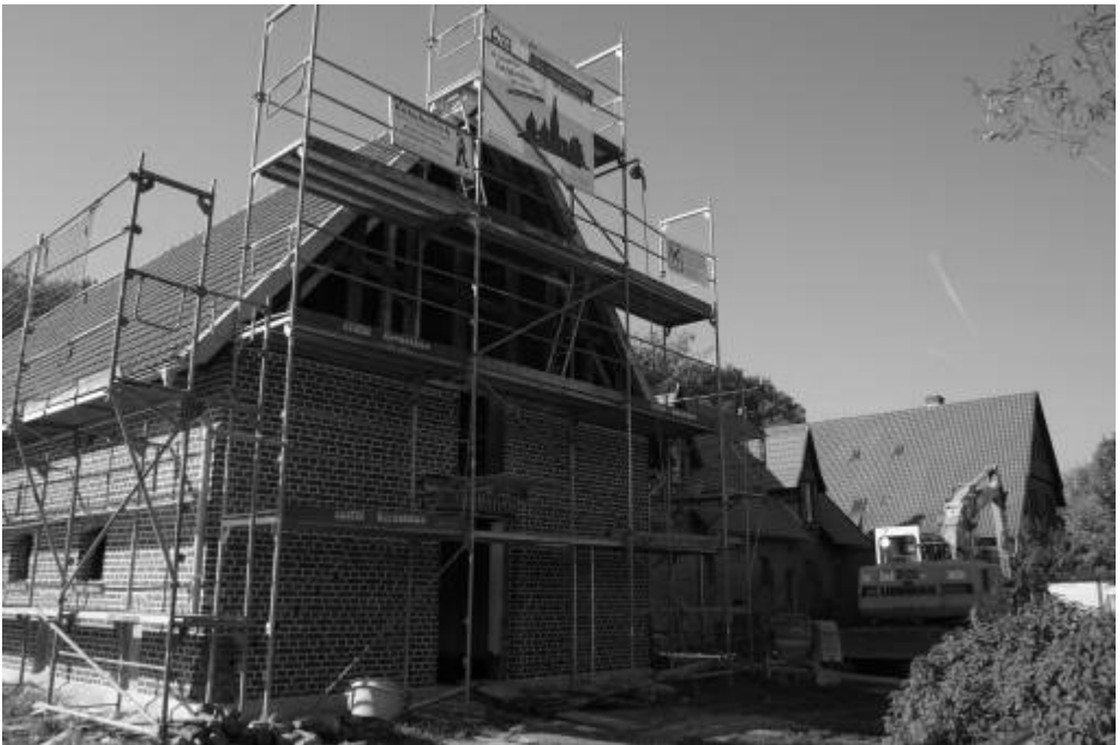
Abb. 2: Die Arbeiten am ehem. Schweinestall sind in vollem Gange ...
